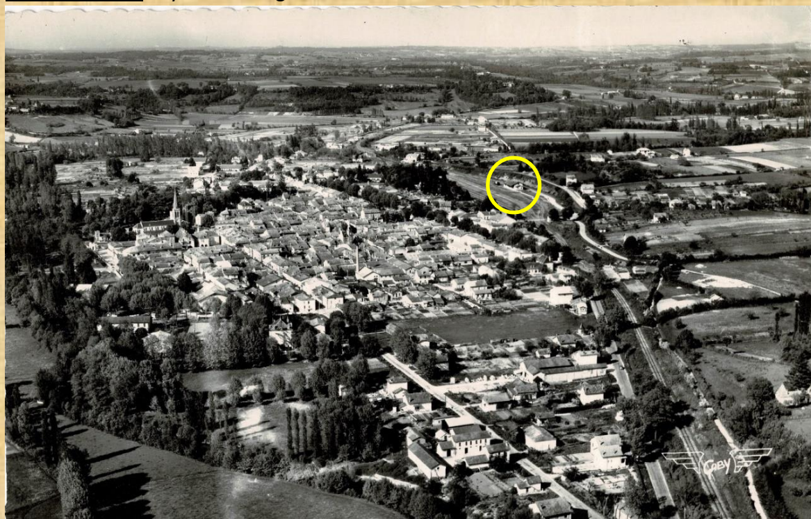
Vue aérienne la commune d'Eymet et de la ligne de chemin de fer et des emprises de la gare dont la halle aux marchandises entourée en jaune, les voies sont quasi vides. (Collec. Eric Comont)
