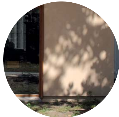
enduit à la chaux sur isolation par l'extérieur fibre de bois bâtiment B
