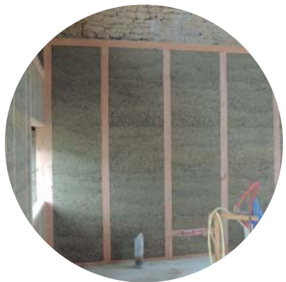
isolation intérieure chaux chanvre bâtiment B
