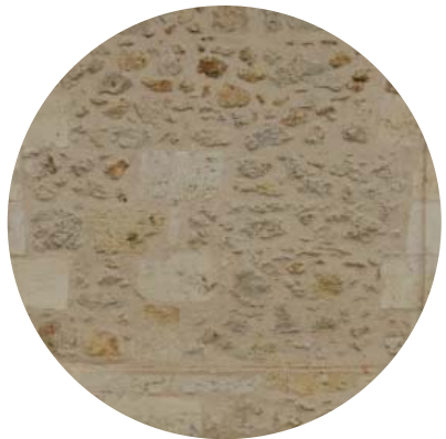
enduit à pierres vues murs extérieurs bâtiment B
