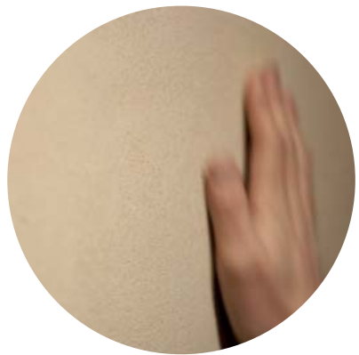
enduit terre sur chaux chanvre projeté
