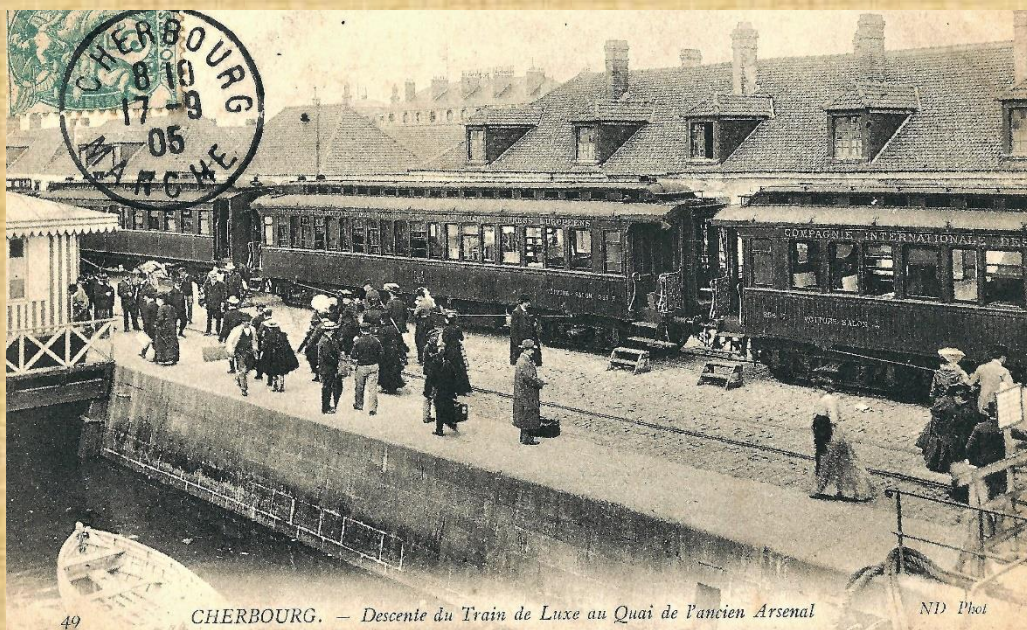
49 CHERBOURG. — Descente du Train de Luxe au Quai de l'ancien Arsenal ND Phot Wagons-Salons n°255 et 256 en gare maritime de Cherbourg, construits aux Ateliers de Nivelles en Belgique en 1889. A noter, les rambardes et les garde-corps très travaillés, et les petits marchepieds pour faciliter la descente des passagers faute de quai... la CIWL avait plein de petites attentions pour ses clients ! Compte tenu du cachet, la photo date du tout début du XX ème siècle. Collec. Eric Comont
