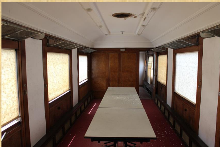
Ci-dessus, vue sur le grand salon, un dégât des eaux au plafond et les panneaux blancs remplaçant les marqueteries Prou volées en 2011. A droite, la vue du compartiment de l'ordonnance avec le lit. Il faut imaginer des boiseries à la place des habillages blanc, le plafond en caisson est en bon état (Collec. E. Comont)
