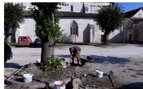
Reprise des massifs du parking de l'église - Septembre
