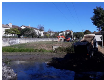
Construction batardeau pour reprise travaux Pont Roman - Octobre
