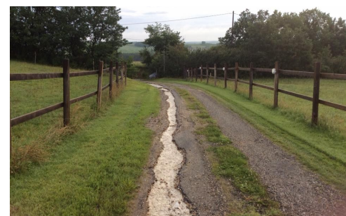
Dégâts constatés après les inonda- tions - Juin
